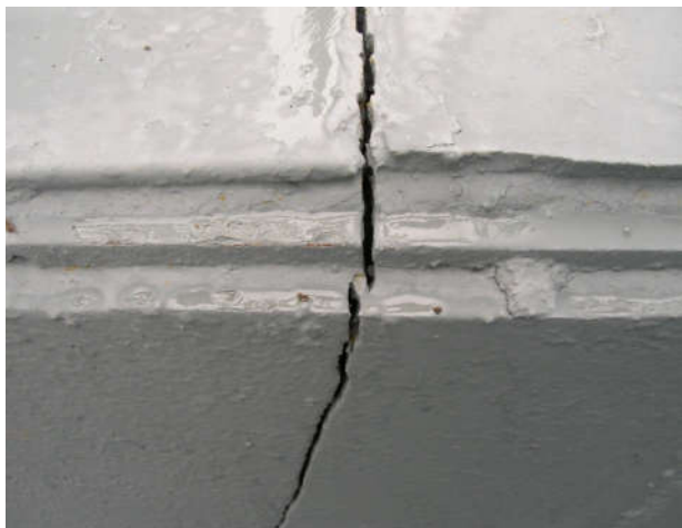
Рисунок 3 – Фрагменты разрушения металлооблицовки при пуске РН «Союз»
